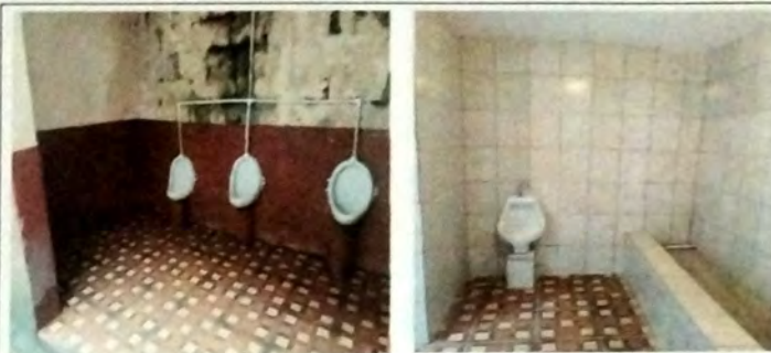
Foto 8:MODULO DE URINALES. Vista de Urinales Instalando azulejos. Se sustituyeron urinales en malas condiciones y se instalaron nuevos.
