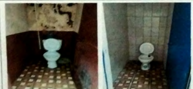
Foto 11: VISTA DE SERVICIO SANITARIO, area de inodoros remozada con aplicación de azulejo y piso cerámico, así mismo se remozaron las puertas de metal.
