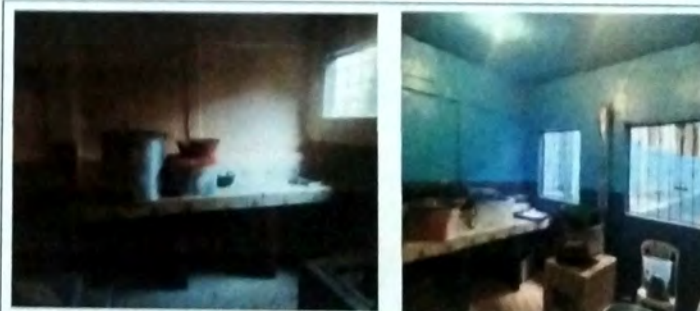
Foto 16: MODULO DE COCINA Vista muros pintados y vanos ampliados.
