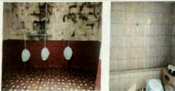
Foto7: MODULO DE URINALES. Vista de Urinales Instalando azulejos. Se sustituyeron urinales en malas condiciones y se instalaron nuevos.
