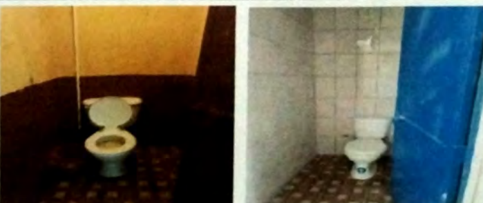
Foto 12: VISTA DE SERVICIO SANITARIO, Area de servicios sanitarios se aplico azulejo en muros, Vista de pila de concreto remozada con aplicación de azulejo.
