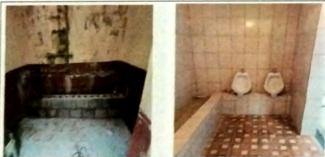
Foto 9: VISTA DE SERVICIO SANITARIO, area de urinal remozada con aplicación de azulejo
