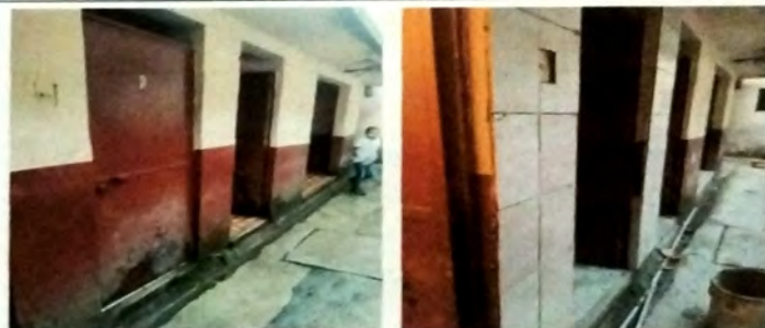
Foto 10: VISTA DE SERVICIO SANITARIO, Vista de puertas de metal en proceso de remozamiento.
